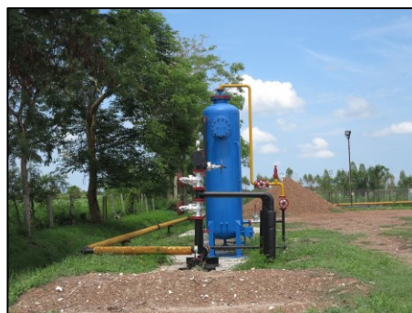
4) ถังวัดปริมาตร (Measuring Tank)
