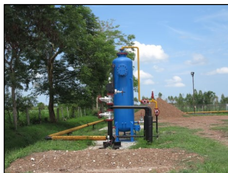
4) ถังวัดปริมาตร (Measuring Tank)
